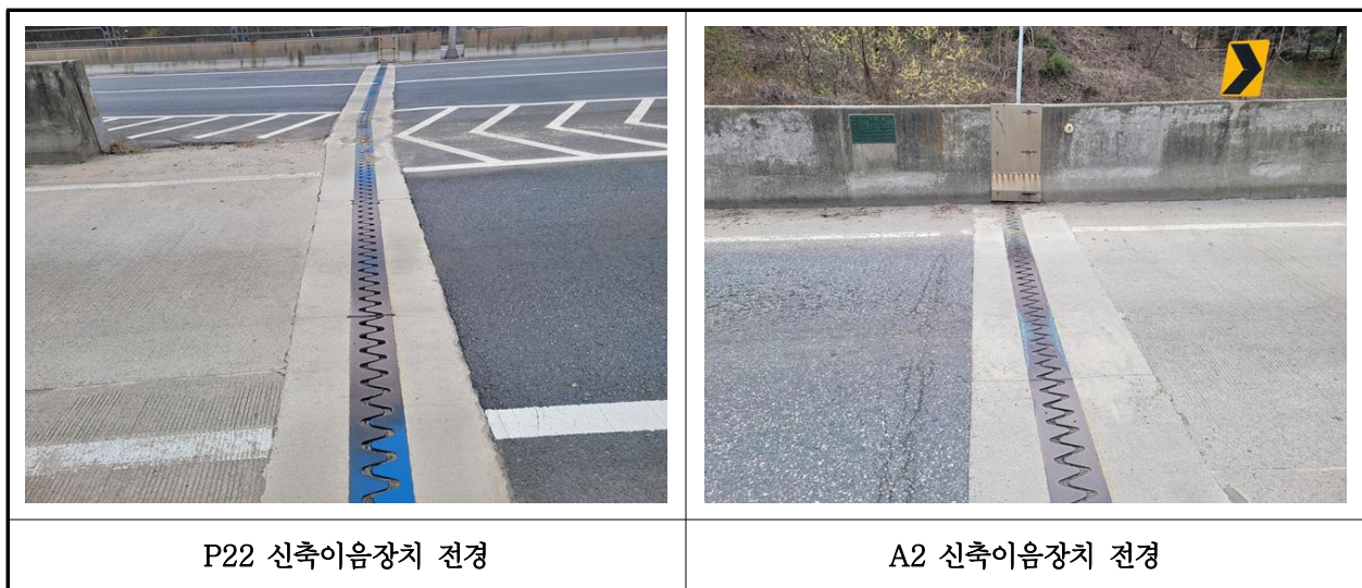
【사진 1.3.16】 신축이음장치 전경
