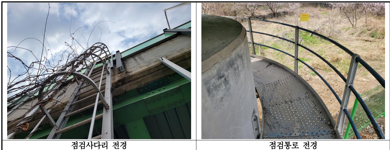
【사진 1.3.25】 교량 점검시설 전경
