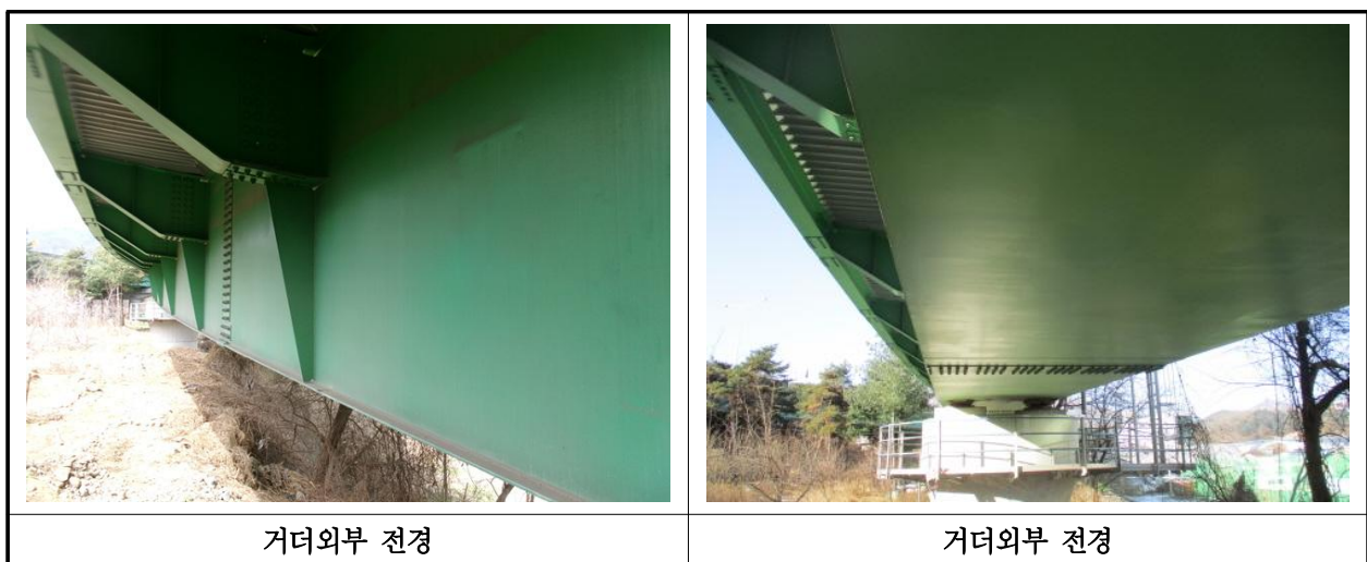
【사진 1.3.4】 거더외부 전경
