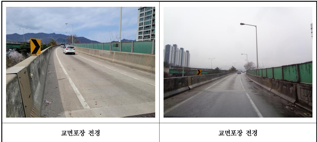
【사진 1.3.19】 교면포장 전경
