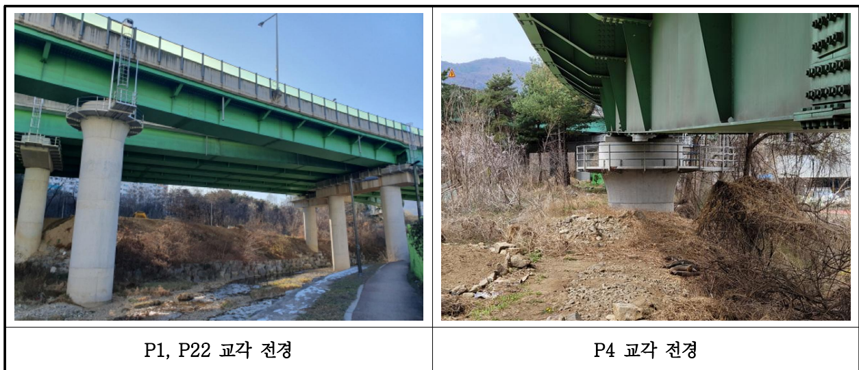
【사진 1.3.12】 교각 전경
