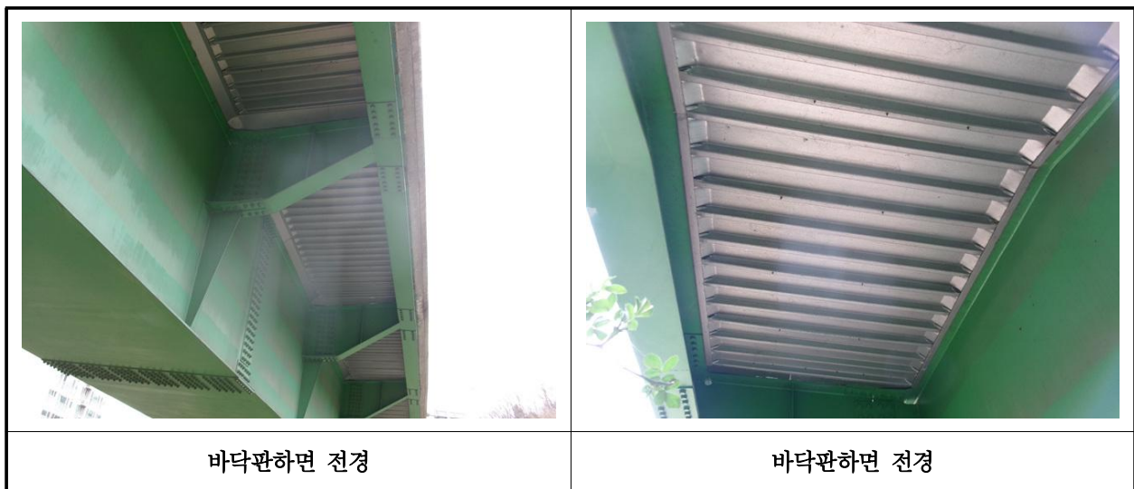
【사진 1.3.2】 바닥판하면 전경
