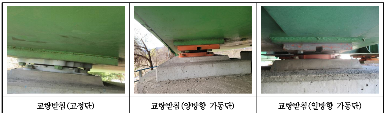
【사진 1.3.14】 교량받침 전경
